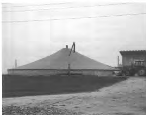
Abb. 1381 Kennzeichen von Biogasanlagen ist fast immer die Folienhaube über dem Fermenter. Unter ihr wird das Biogas gesammelt.
